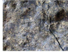
アスファルト拡大
