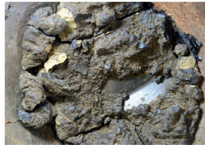
アスファルト拡大
